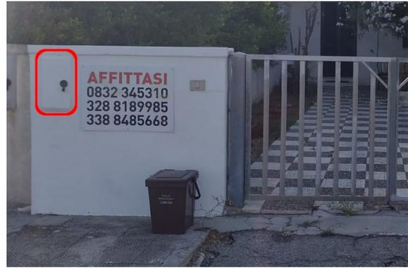
Si deve aprire lo sportello ruotando il meccanismo di chiusura in senso antiorario e rialzare l'interruttore, eliminando la causa del sovraccarico per prevenire una nuova interruzione.
